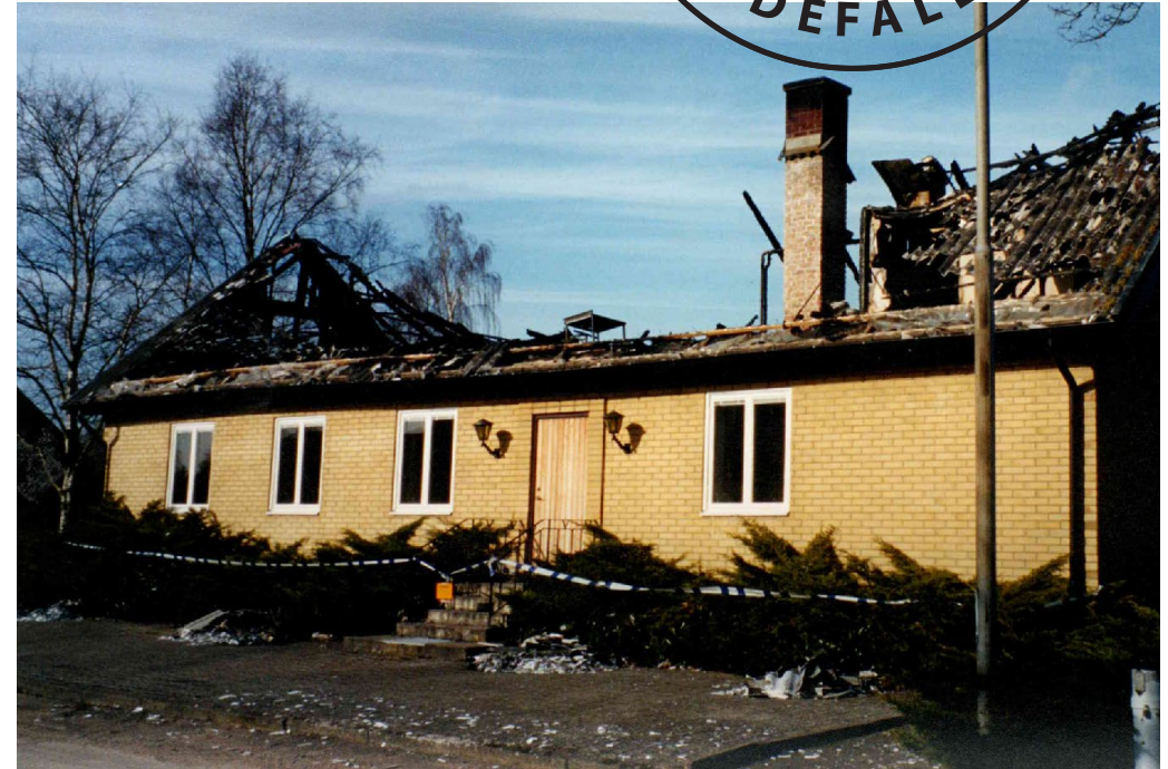
Efter att ha oljat golv lades använda trasor i platsäck som sedemera fattade eld.
