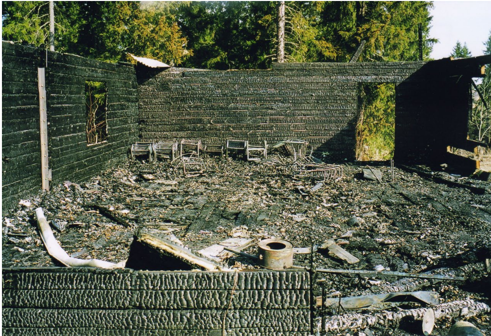
Vid golvslipning uppkom gnistor i slipmaskinens slipdamm orsakade av att man slipat på spik/skruv.
